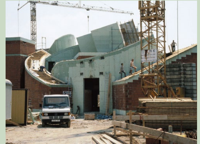
Le Vitra Design Museum de Frank Gehry en cours de construction
