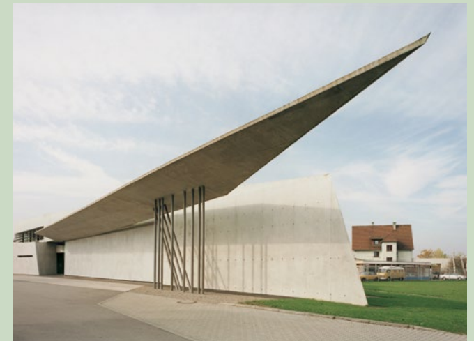
La caserne de pompier de Zaha Hadid
