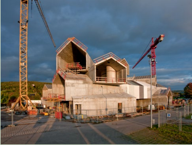
La VitraHaus de Herzog & de Meuron en construction
