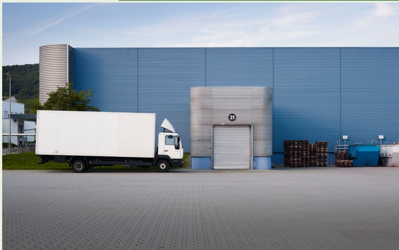
La halle de production de Nicolas Grimshaw sur le Vitra Campus à Weil am Rhein
